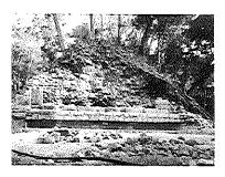
6. Se superviso los trabajos de restauración en el cuerpo norte superior del edificio B-18 en el sitio arqueológico Naranjo y como parte del proceso se trabajó en la estabilización de 25 m² de muros en la fachada norte lado este de los taludes liberados.
